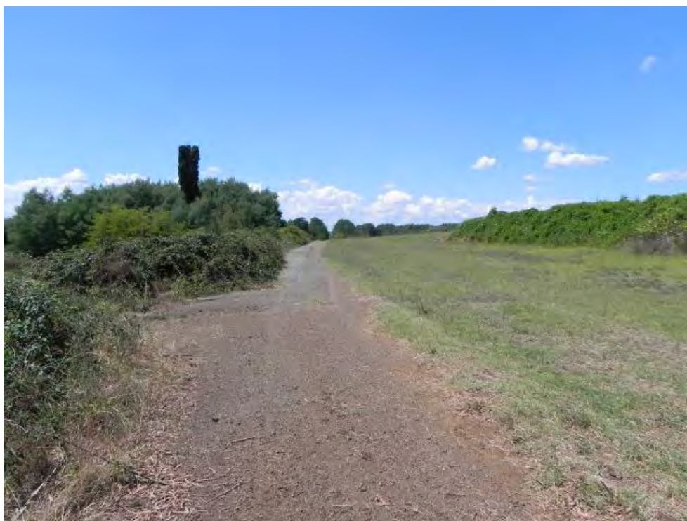
Figura 4.2 – Strade non pavimentate.
