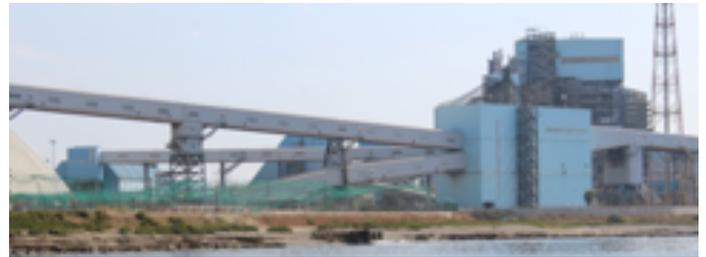
**Fig. 7 dettaglio sui nastri trasportatori**
