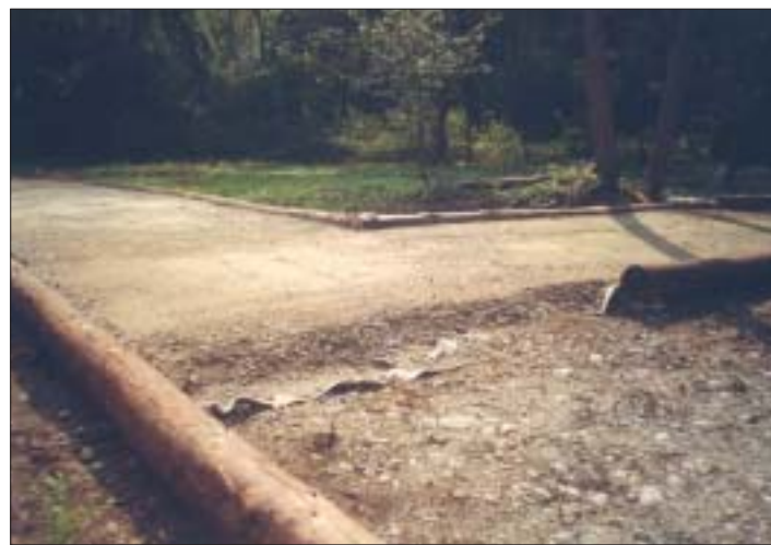
Foto n. 40 - Bosco delle Fontane a Cison del Grappa (VI), pavimentazione in costruzione di un percorso accessibile.
