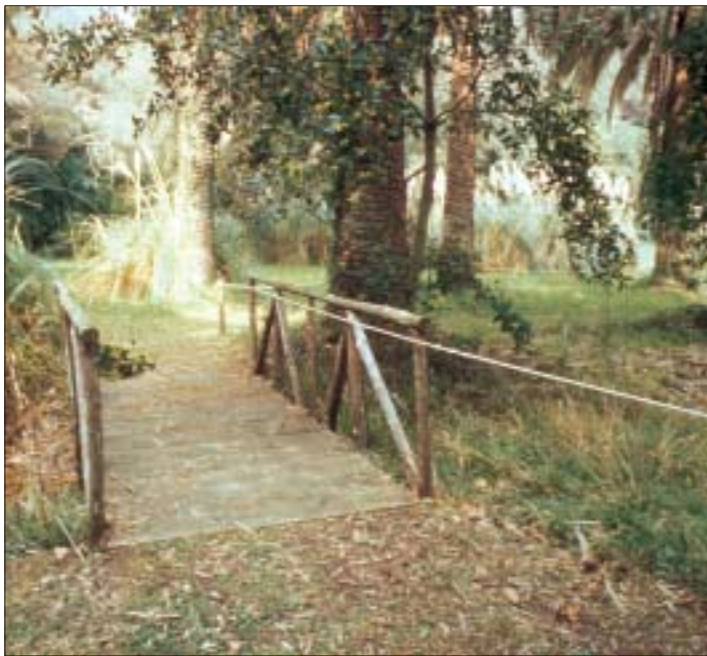
Foto n. 50 - Parco Nazionale del Circeo, Lazio: corrimano in corda con triplo nodo in corrispondenza di una passerella.
