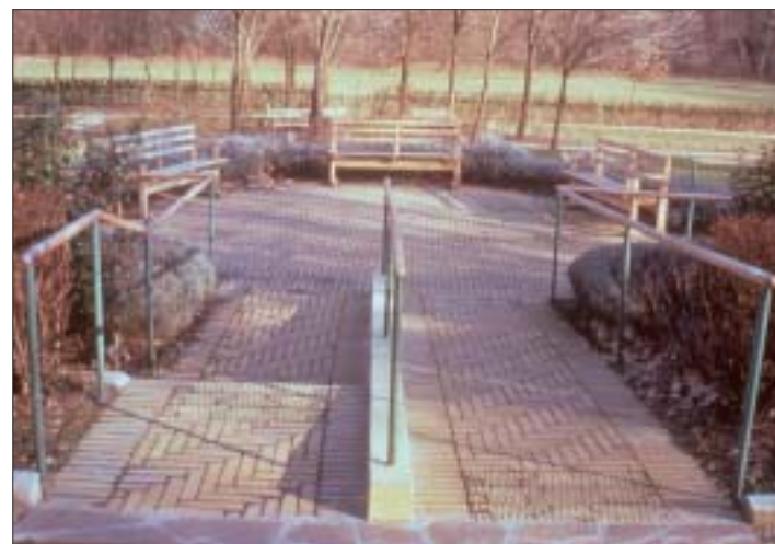
Foto n. 55 - Centro diurno integrato per anziani Cascina di Costa Bassa, Parco di Monza: accesso al percorso con scala e rampa.
