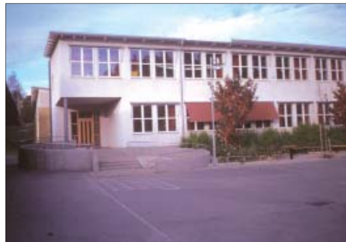
Foto n. 54 - Rampa e scala sono giustamente integrati in questo manufatto d'ingresso ad una scuola primaria svedese.
