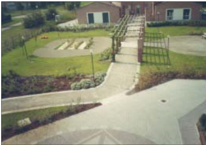
Foto n. 41 - Reggio Emilia, Centro Tagliavini Ferrari, le differenti pavimentazioni sono funzionali anche alla segnaletica a terra.
