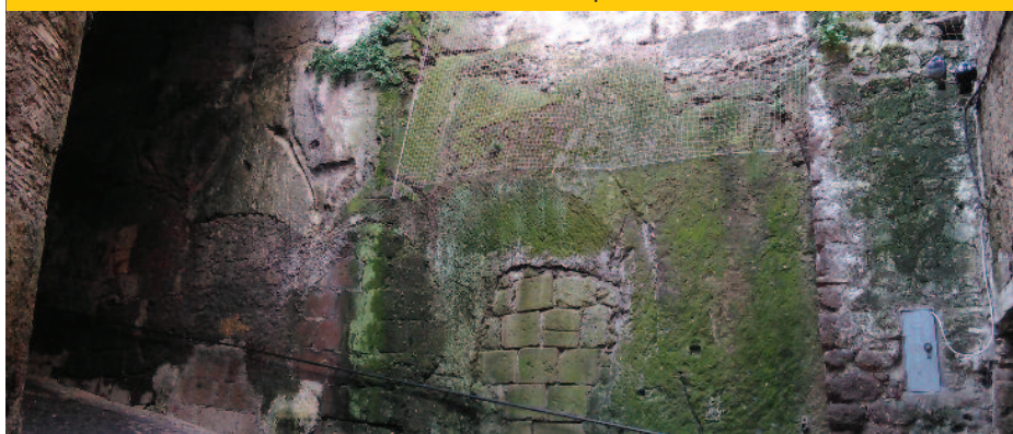
Una delle reti installate sulla parete di tufo
