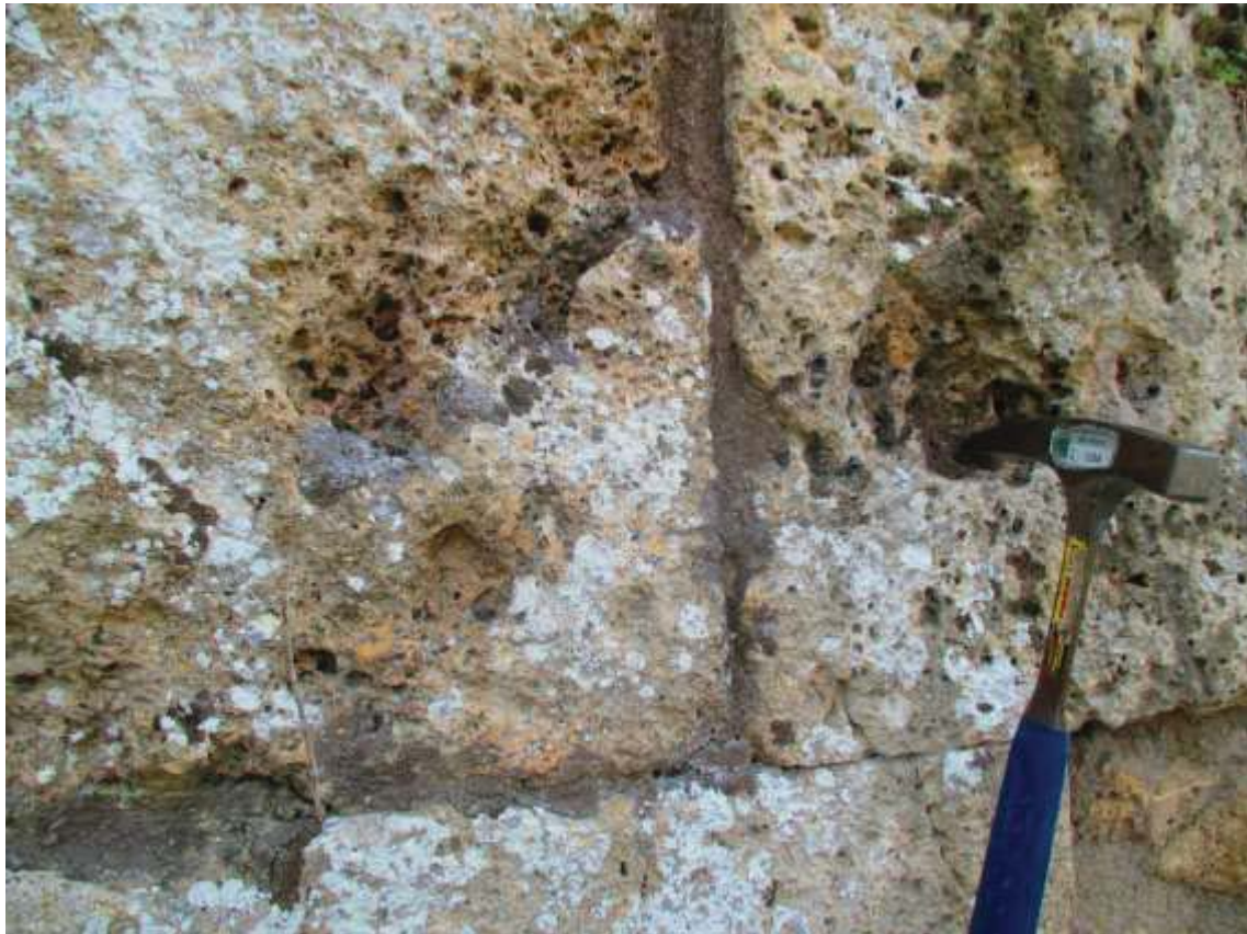
Particolare di Porta Capuana che evidenzia la costituzione travertinosi dei blocchi
