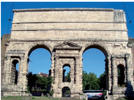
Porta Maggiore (Arch. Iter)
