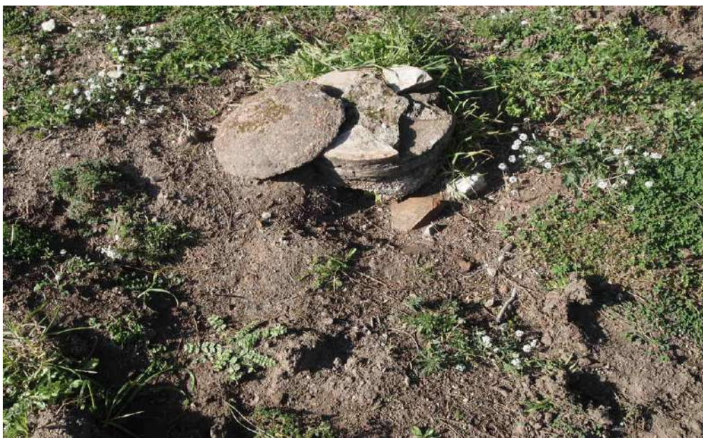
Il suolo dell'area archeologica della Villa di Plinio presenta le tracce lasciate dai cinghiali: sono evidenti i danni alle strutture murarie, come nel caso della foto dove la base di una colonna in laterizio oggetto di restauro appare divelta. (Foto D. Mantero 2016)
